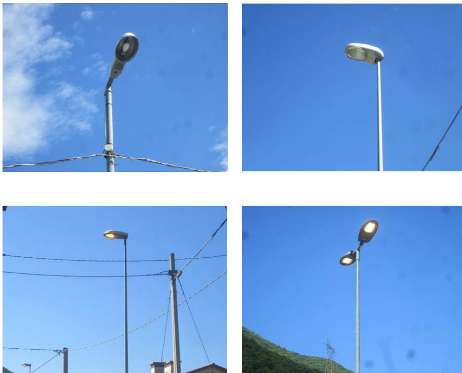
Figura 9 – Corpi illuminanti con armatura stradale
