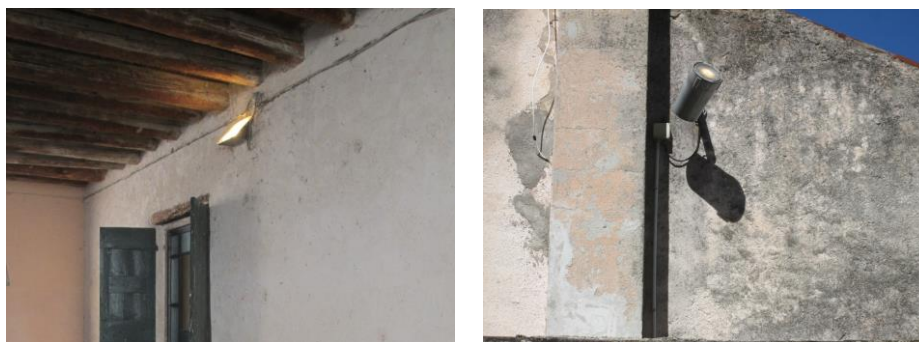
Figura 12 – Corpi illuminanti tipo proiettore
